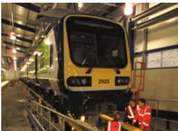
Nouveau dépôt ferroviaire à Drogheda (Irlande)
